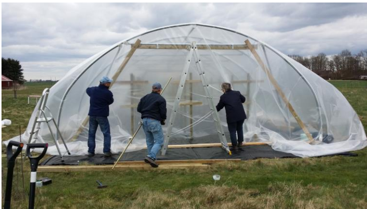
Figur 3. Montering av plasten på tunneln.
