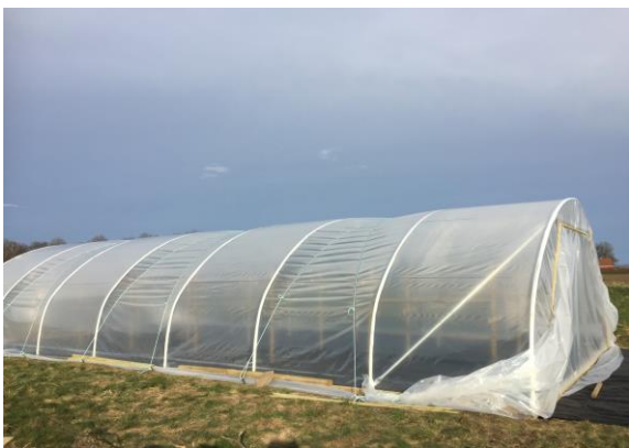
Figur 4. Montering av tunneln färdig.
