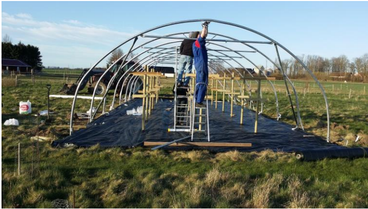
Figur 2. montering av tunneln.
