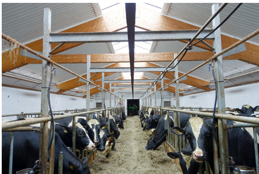
Figur 1. Interiör från nybyggt ungnötsstall med helpaltboxar och foderbord med rälsbunden utfodring
